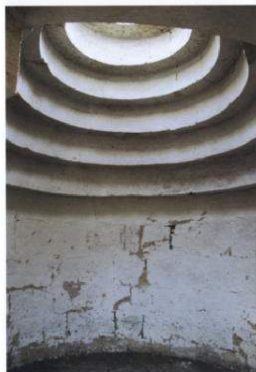
Рис. 40. Схема устройства склепа с уступчатым перекрытием
