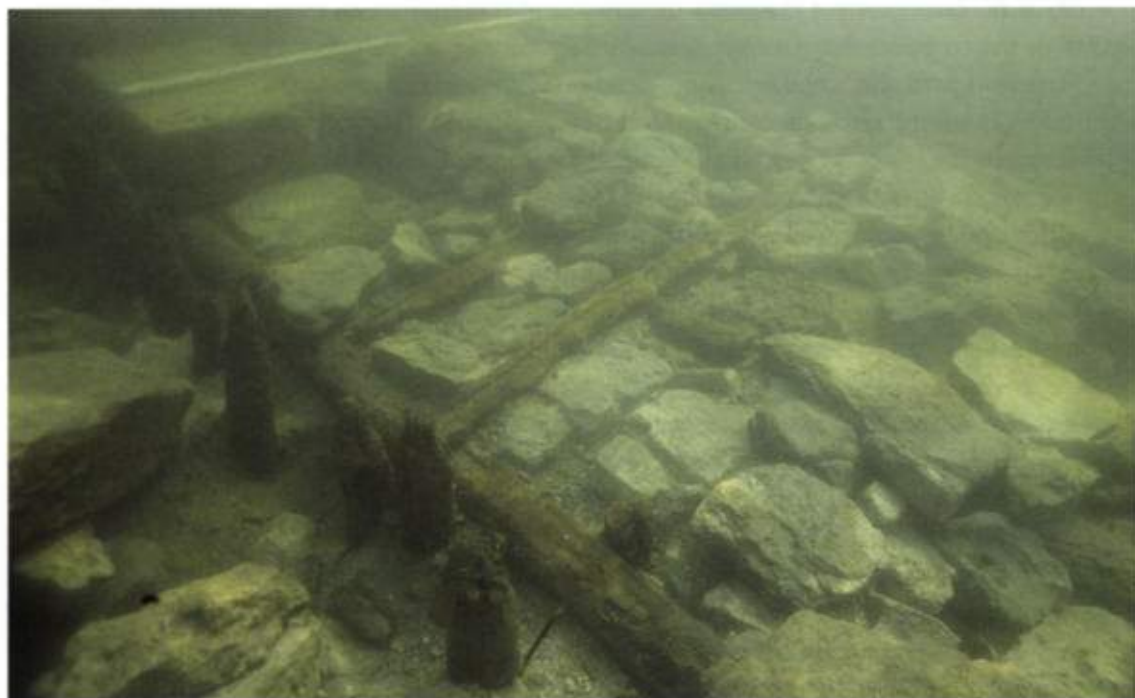
Рис. 6. Подводный фундамент — ряж
