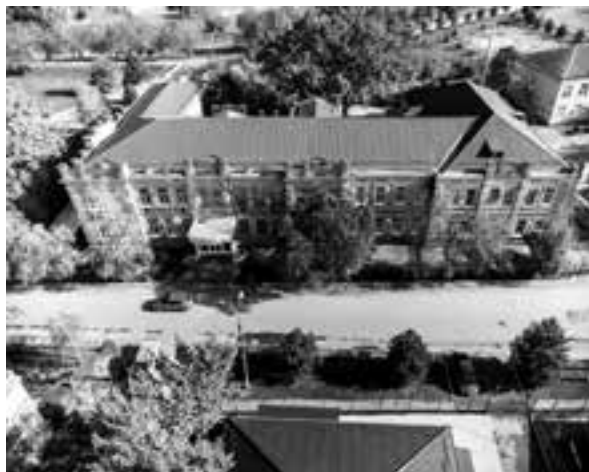
Вид на здание Управления Таманского отдела. Ныне ГБПОУ КК Славянский сельскохозяйственный техникум
