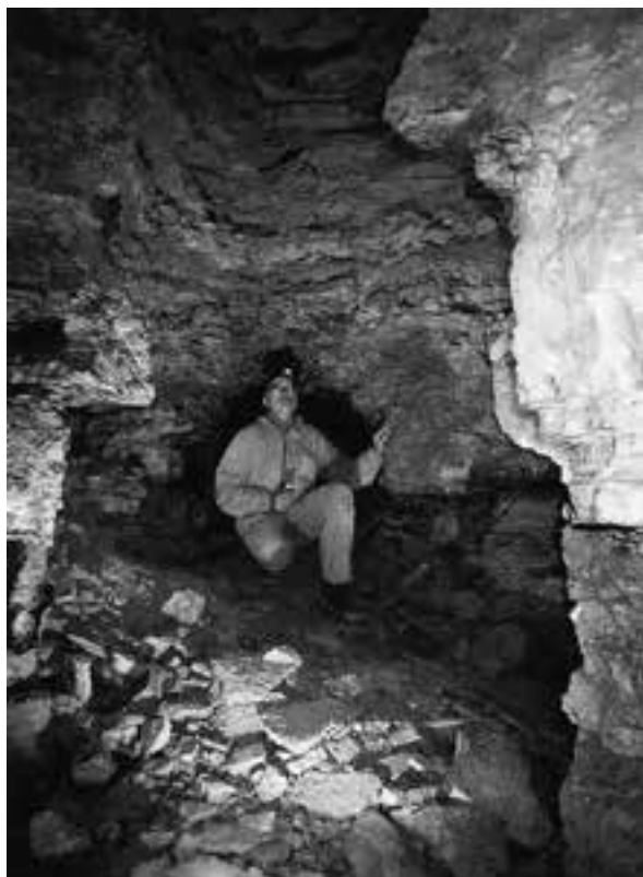
Рис. 7. Каменоломня Покрово-Казачья-1а. Забой и купол вывала у т. № 23
