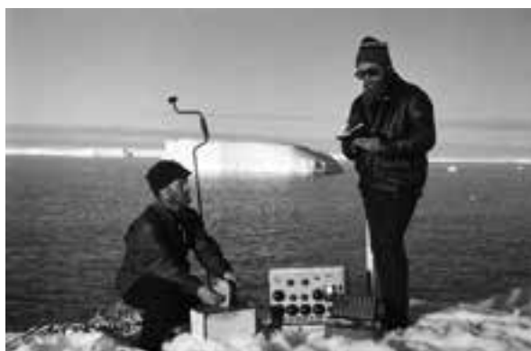
Выполняемые нами работы по строительству ледяного причала в Антарктиде вблизи станции «Молодёжная» были сопряжены с большими трудностями
